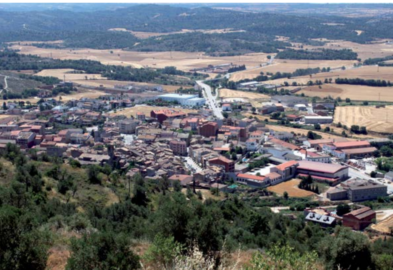
Vista general de Torà
